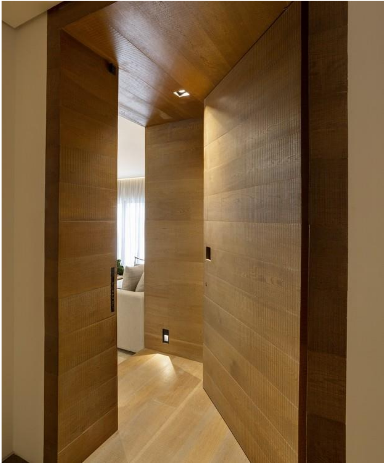
O hall de entrada é uma grande caixa de madeira, de carvalho europeu tingido. O piso é da Parket e do mesmo material
